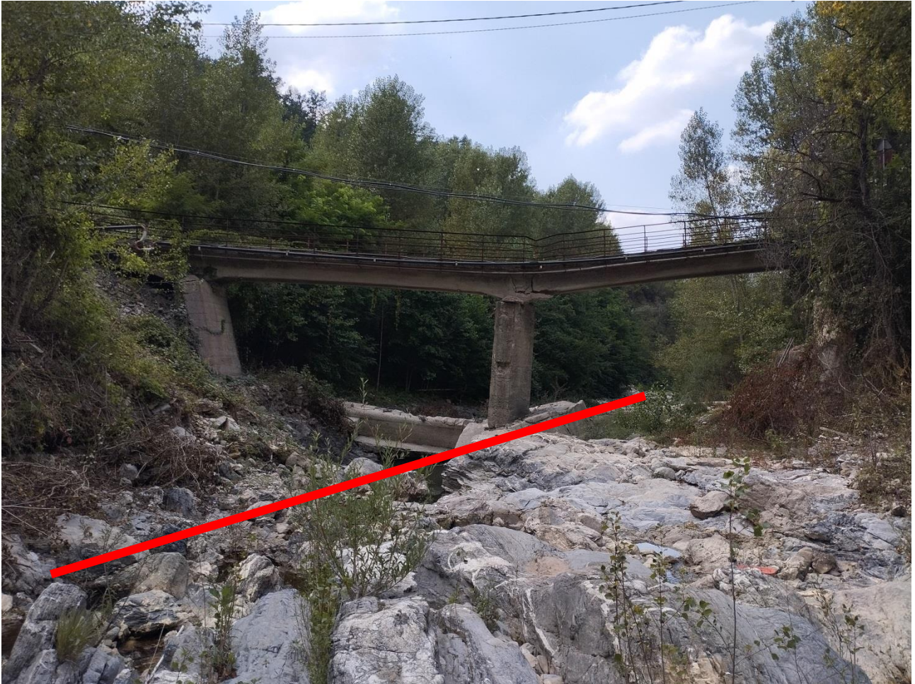
figura 23: vista verso valle con indicativa linea di "confine" tra argilliti (a sinistra) e calcari dell'Antola (a destra)
