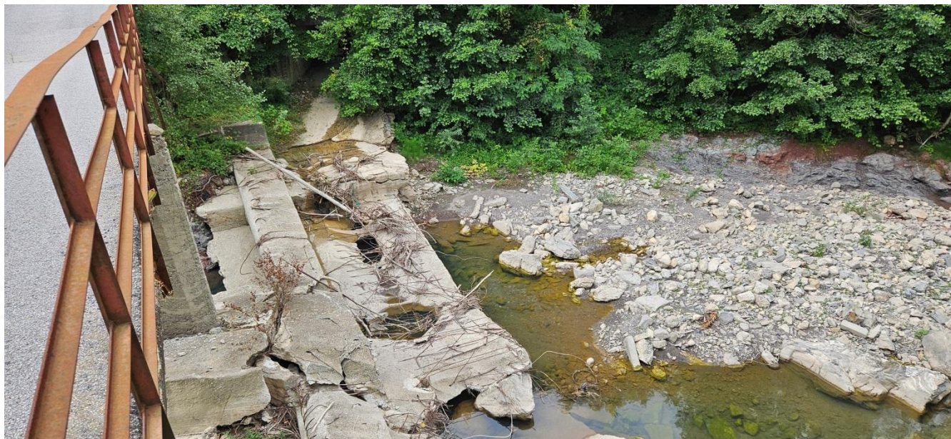
figura 5: condizione agosto 2024 briglia esistente immediatamente a valle ponte di Noceto
